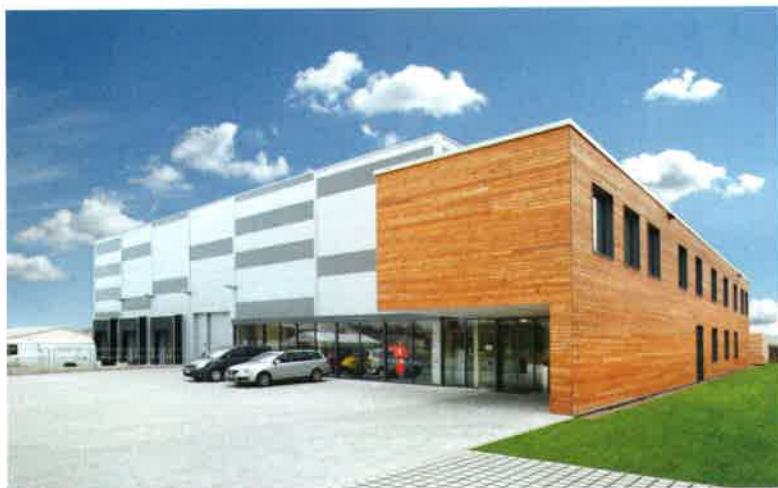
Der Neubau von Niemann-Laes Industriebedarf in Lüneburg mit einer Fassadengestaltung aus Holz- und Metallelementen
