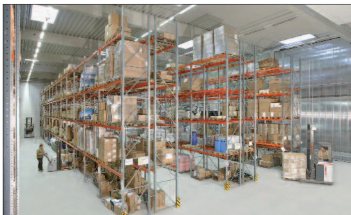
In der 7,5 Meter hohen Meta Multipal®-Palettenregalanlage werden Großteile und Produkte auf Paletten in großer Menge sicher gelagert.
